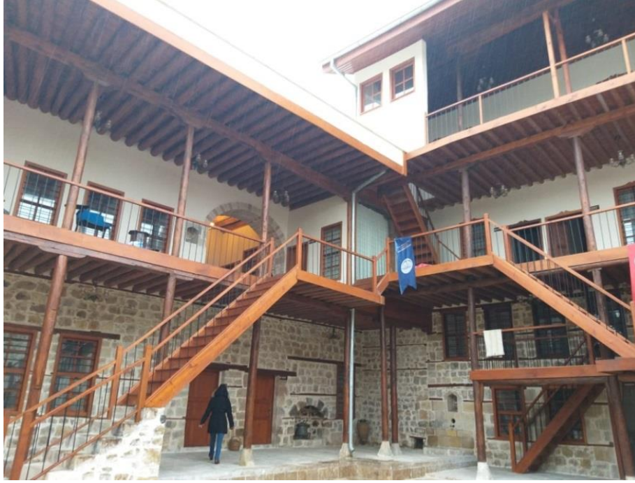
Fotoğraf 40. Üdürgücüler Konağı Restorasyon Sonrası Diğer Bölümler (Hatice Kübra ATICI'nın Arşivinden)
