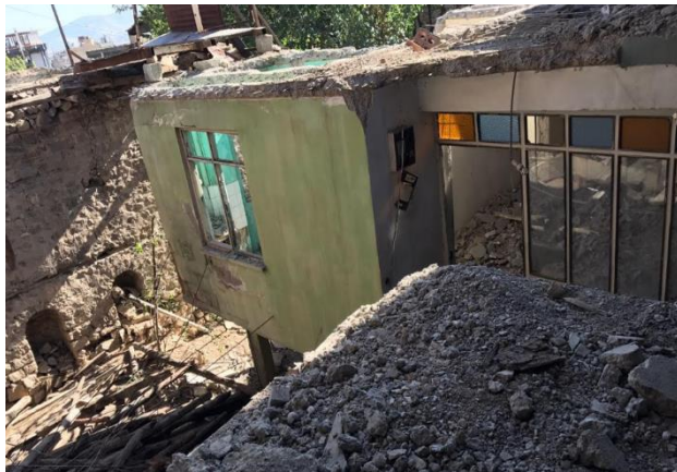
Fotoğraf 32. Betonarme Eklenti Yıkım Aşaması (Kahramanmaraş Büyükşehir Belediyesi Arşivi)
