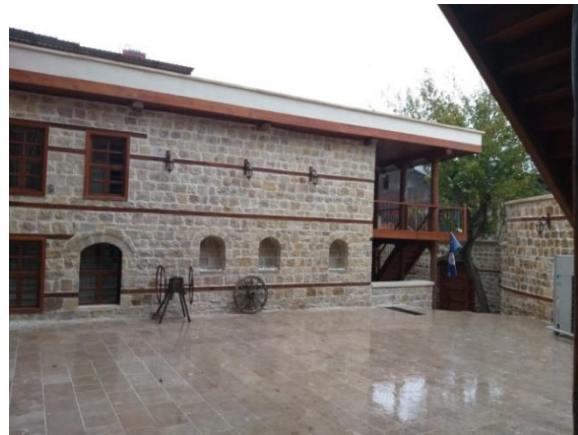
Fotoğraf 39. Restorasyon Sonrası Mezarların Üstündeki Yapı (Hatice Kübra ATICI'nın Arşivinden)
