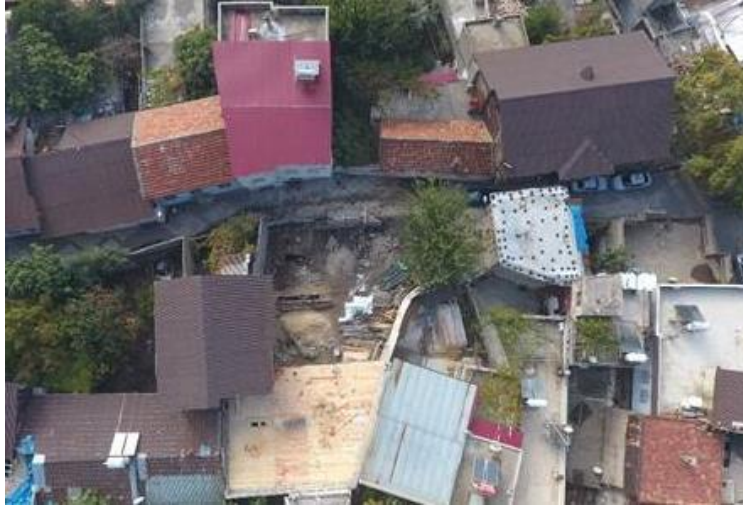
Fotoğraf 34. Üdürgücüler Konağı Restorasyon Aşaması (Kahramanmaraş Büyükşehir Belediyesi Arşivi)
