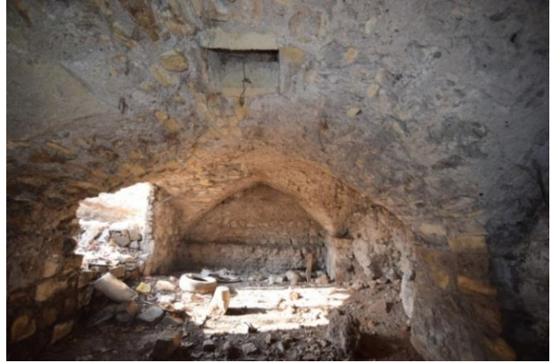
Fotoğraf 19. Kahramanmaraş Arslan Bey Konağının Restorasyonu Sırasında Çıkan Kaya Mezarları (Kahramanmaraş Büyükşehir Belediyesi Arşivi)
