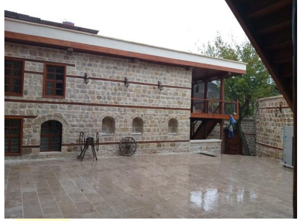
Fotoğraf 18. Restorasyon Sonrası Mezarların Üstündeki Yapı ( Hatice Kübra ATICI'nın Arşivinden)
