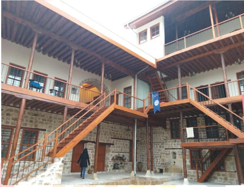
Fotoğraf 19. Üdürgücüler Konağı Restorasyon Sonrası Diğer Bölümler ( Hatice Kübra ATICI'nın Arşivinden)
