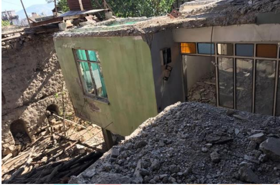
Fotoğraf 13. Betonarme Eklenti Yıkım Aşaması (Kahramanmaraş Büyükşehir Belediyesi Arşivi)
