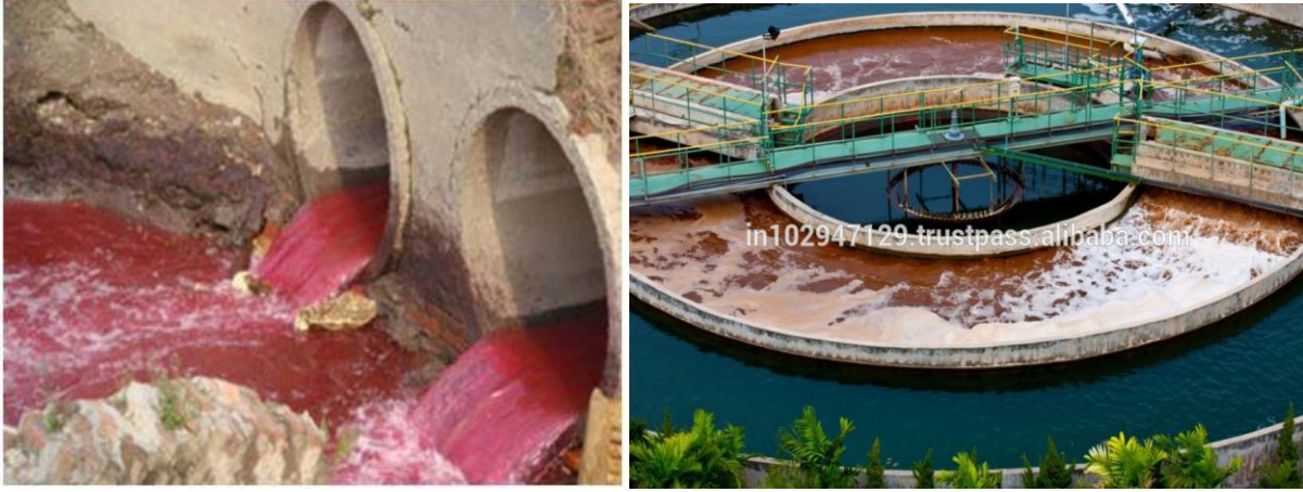
Resim 8,9 . Bir tekstil işletmesinin atık suları ve arıtma tesisi.
