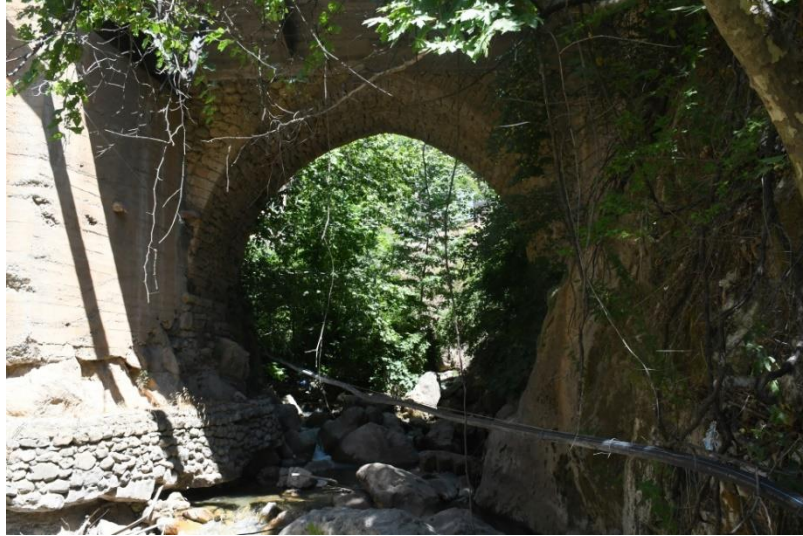
Şekil 6: İslam Mahallesi Taş Köprüsü mansap cephesinden genel görünüm
