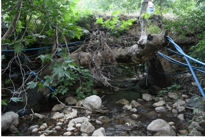
Şekil 8: Obruk Yolu Taş Köprüsü mansap cephesi görünümü
