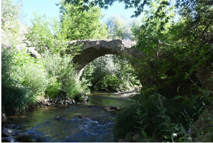
Şekil 2: Himmetli Köprüsü mansap cephesinden genel görünüm
