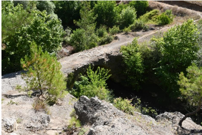
Şekil 1: Himmetli Köprüsü genel görünüm
