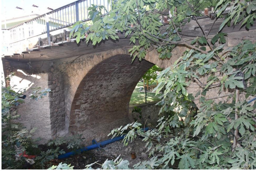
Şekil 3: Fatih Mahallesi Taş Köprüsü mansap cephesinden görünüm
