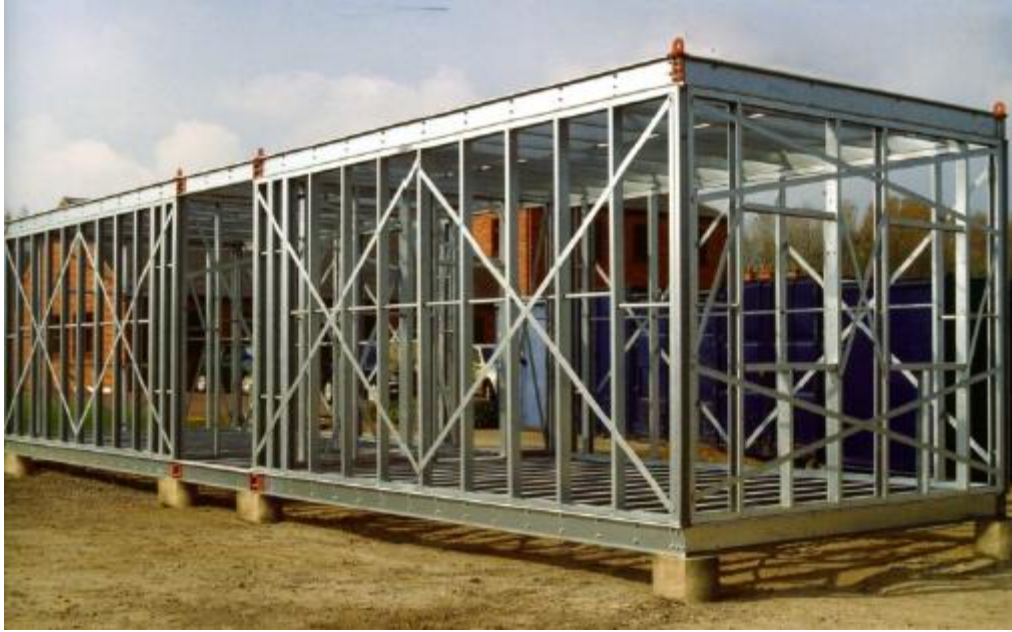
Şekil 12. Modül sistem (Iorio, 2009)
